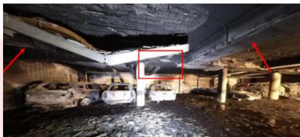
Foto 2: Brandbeeld uitgebrande personenauto's in rood het voertuig dat als eerste vlam vatte.
