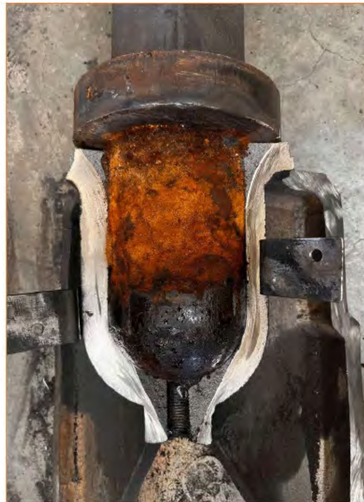
Figuur 30, onderzijde spil in de kolomvoet
