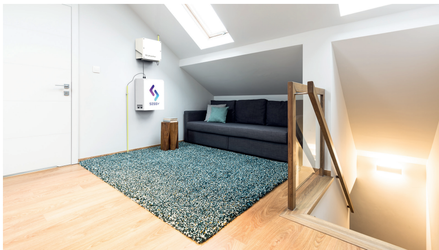
Er kunnen redenen zijn voor een gemeente om nadere regels te stellen over thuisbatterijen, bijvoorbeeld vanwege brandveiligheid. Thuisbatterijen kunnen daarnaast ook impact hebben op het elektriciteitsnet.
