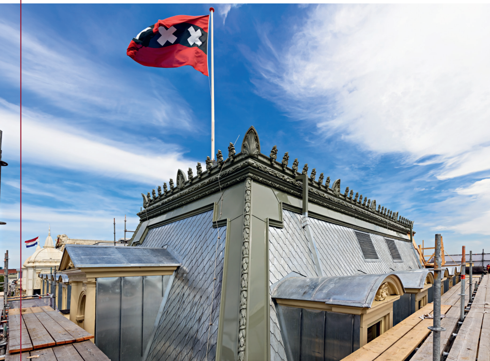
Restauratie van de buitenzijde van het Amstel Hotel in 2018.
