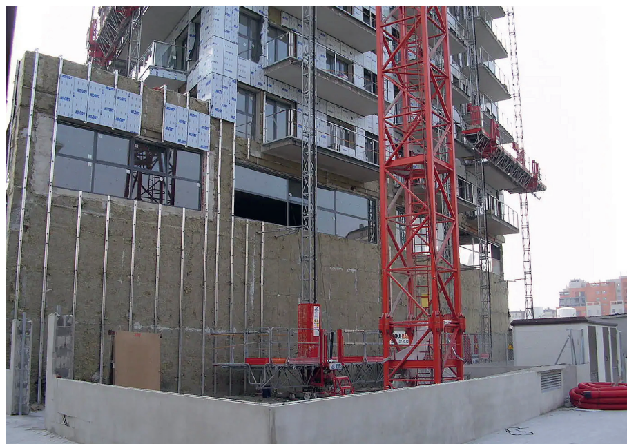
Appartementencomplex in Valencia in aanbouw.
