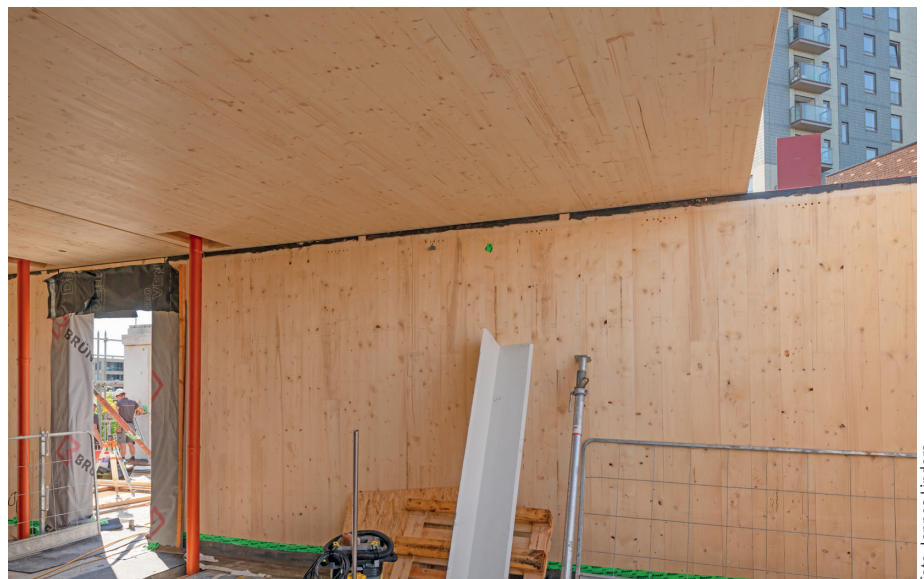
HAUT in Amsterdam: een hybride houten gebouw van 73 meter hoog met 21 verdiepingen.
